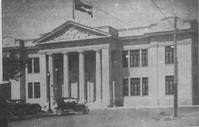
Fachada del edificio que ha sido construido en la ciudad de Cienfuegos para escuela de Artes y Oficios, a expensas del benefactor don Nicolás Acea y de los Ríos.
